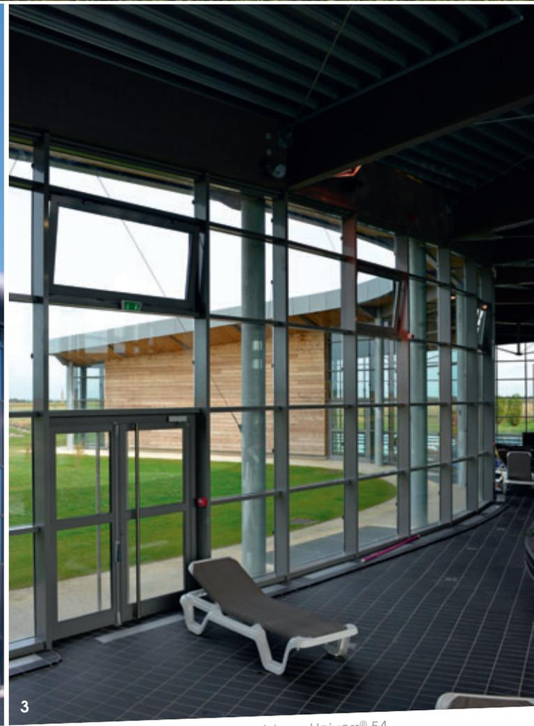
1 Fenêtres et châssis fixes Espace® 50 TH et portes Comète® 50 TH à clamer - 2 Fenêtres Espace® 50 TH dans mur-rideau Univers® 54
